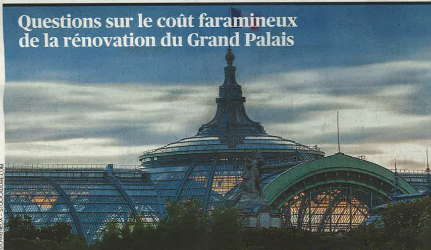
L'annonce du montant des travaux nécessaires à la restauration de ce bâtiment de Paris devenu iconique, près de 500 millions d'euros, suscite une polémique. Ce chantier mérite-t-il une facture aussi élevée? PAGE 30
